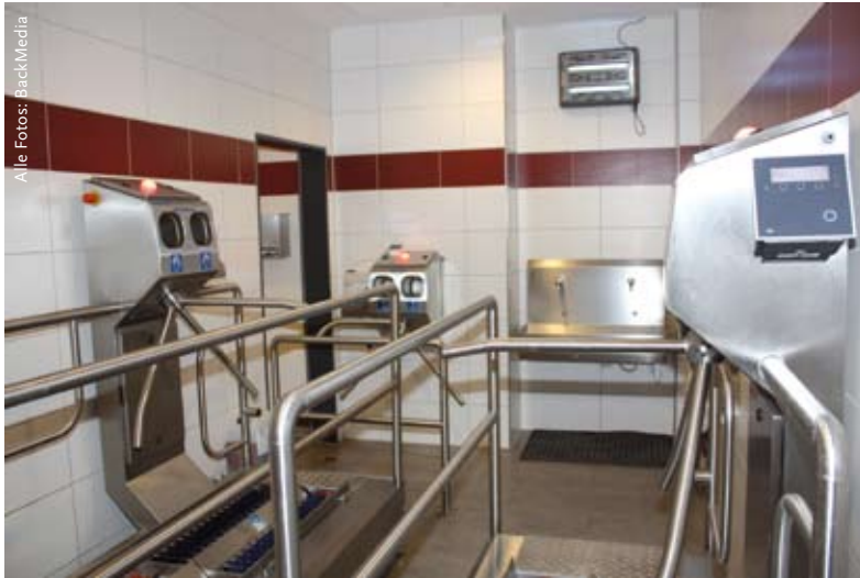
Maik Starke demonstriert die Funktionsweise der Hygieneschleuse, die über einen Chip in Kombination mit der Erfassung der Arbeitszeit unter Einhaltung der definierten Wasch- und Reinigungszeiten durchschritten wird. So ist sichergestellt, dass nicht nur die Hände, sondern auch das Schuhwerk der Mitarbeiter vor dem Betreten der Produktion gesäubert wird.
